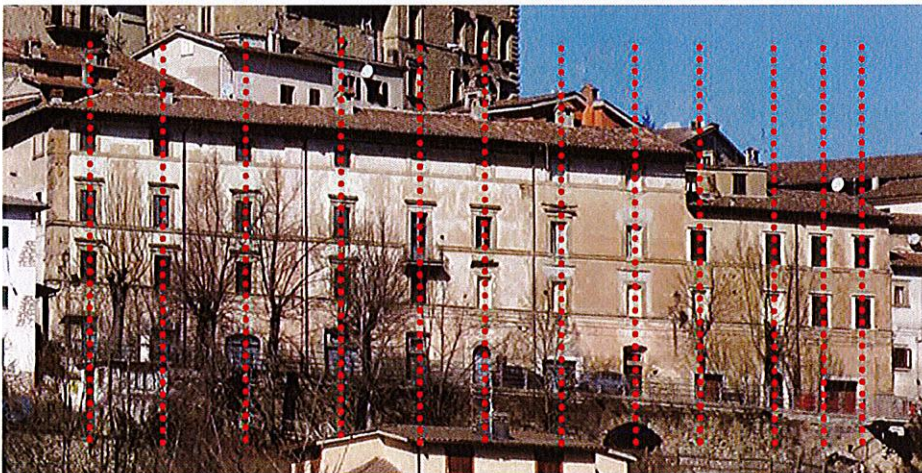
Fig. 15_ Scansione del fronte su Via delle Rimembranze: individuazione degli assi delle bucaure.
