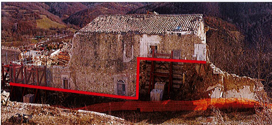
Fig. 11_Linea di demarcazione tra porzioni da demolire e da conservare.
