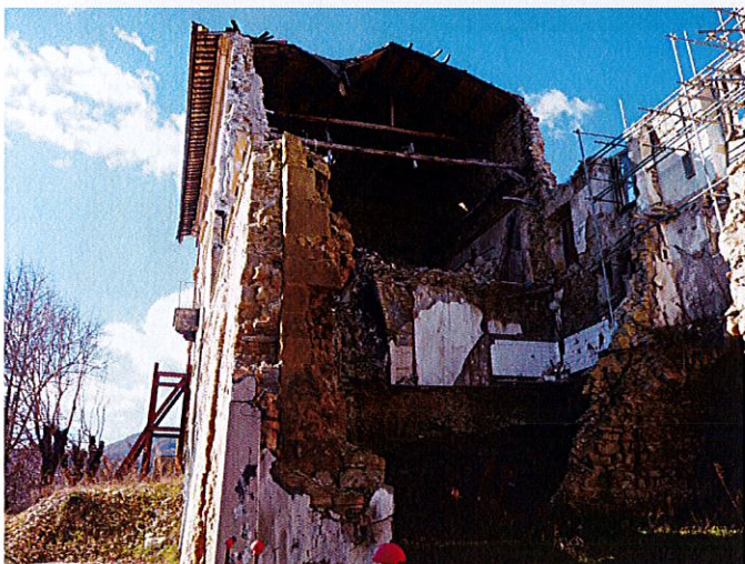
Fig. 10_Doppia fodera della part. 362, quella più interna appartiene al primo impianto del palazzetto binato cinquecentesco.
