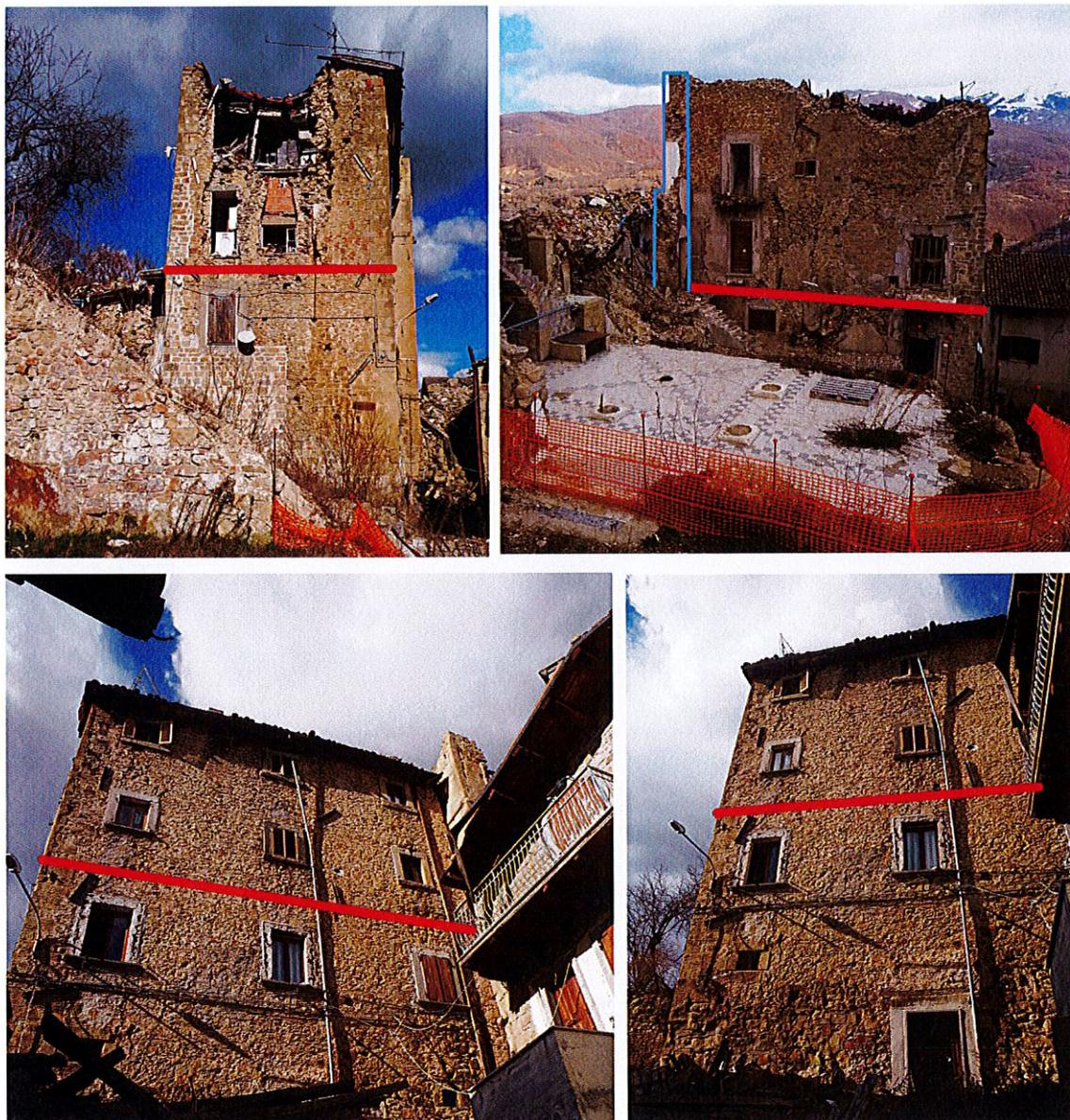
Fig.4\_ In rosso la linea di demolizione; in azzurro la parete di spina di Palazzo Cappello
