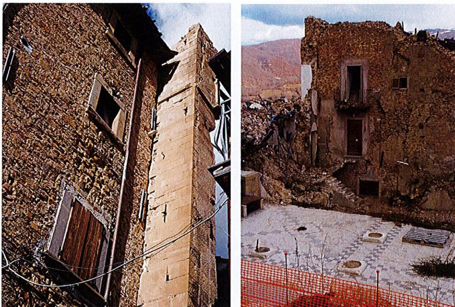
*Fig.3\_ Il muro di spina di Palazzo Cappello su via Piave e sul fronte interno retrostante.*
